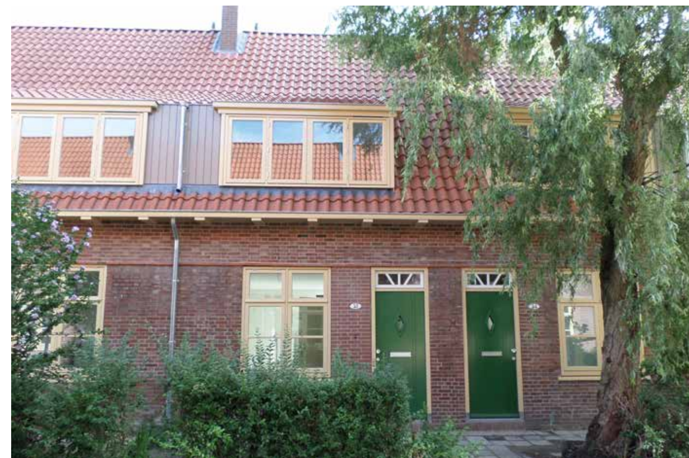
De gerenoveerde buitenschil, met o.a. authentieke dakkapellen en nieuwe dakpannen, deuren en ramen.
