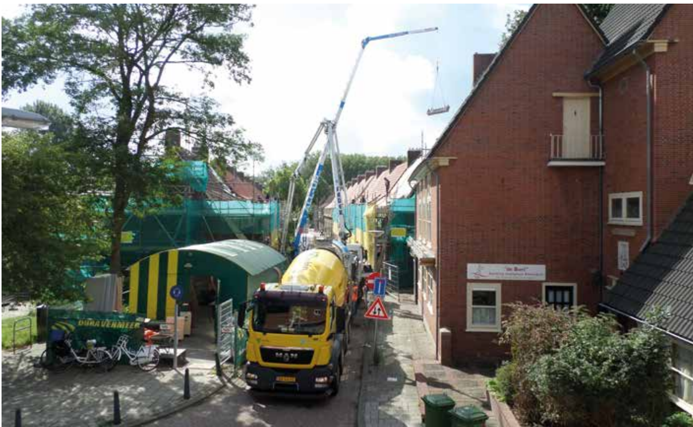
Renoveren in Vreewijk is een logistiek hoogstandje
